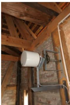
Am 20. und 21.1.2022 wurde dann der elektronische Turmuhrenantrieb eingebaut. Dazu wurden zwei Zifferblattantriebe eingebaut (s. Foto), ein Magnethammer sorgt für den Halb- und Vollschläge an der Glocke, die Funkhauptuhr war bereits vorhanden. Die Turmuhr soll nun sekundengenau gehen, es erfolgt eine automatische Sommer- und Winterzeitumstellung und es gibt eine Verriegelung zwischen Schlägen und Läuten.
